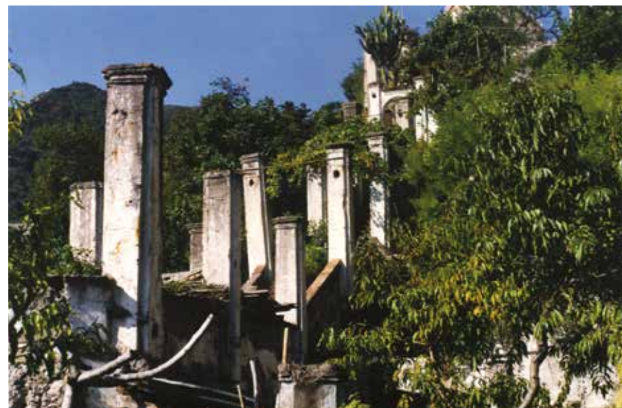
Alcune immagini del giardino, prima dei lavori di restauro
